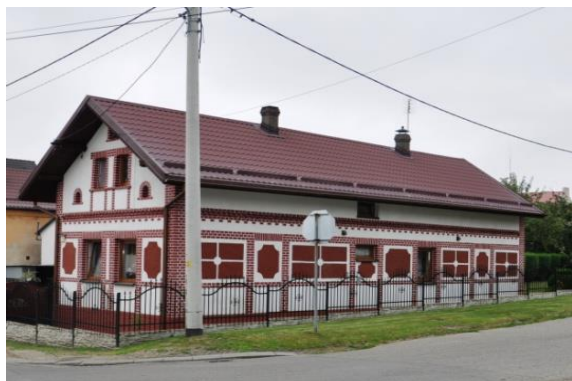
Rysunek 16 Zabudowa przy ul. Wyzwolenia w Pietrowicach Wielkich
